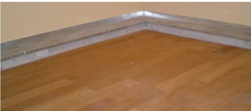
In seguito è stato posato il parquet flottante a secco ed eseguita nuovamente la misura di rumore di calpestio. Infine, dopo rimozione del rivestimento in legno, sono state applicate le piastrelle in ceramica mediante collante cementizio tradizionale ed è stata eseguita una nuova misurazione.
