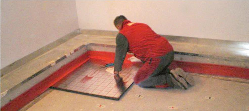
Il sistema radiante europus-silentium è stato installato sopra massetto alleggerito e in prossimità dei bordi della cornice di prova è stata applicata la striscia perimetrale doppia avendo cura di risvoltare il lembo superiore sopra al pannello europus-silentium.
