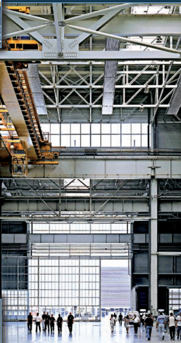
TERMOSTRISCE RADIANTI DUCK STRIP : AEROSPATIALE TOULOUSE FABBRICA DEL NUOVO AEREOPLANO AIRBUS A380 ALTEZZA DI INSTALLAZIONE: 40 m
