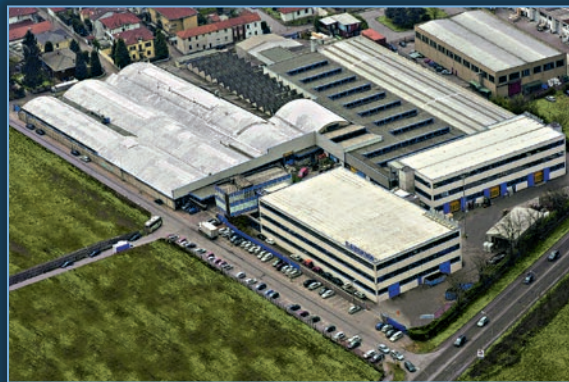
Lo stabilimento Sabiana di Corbetta
